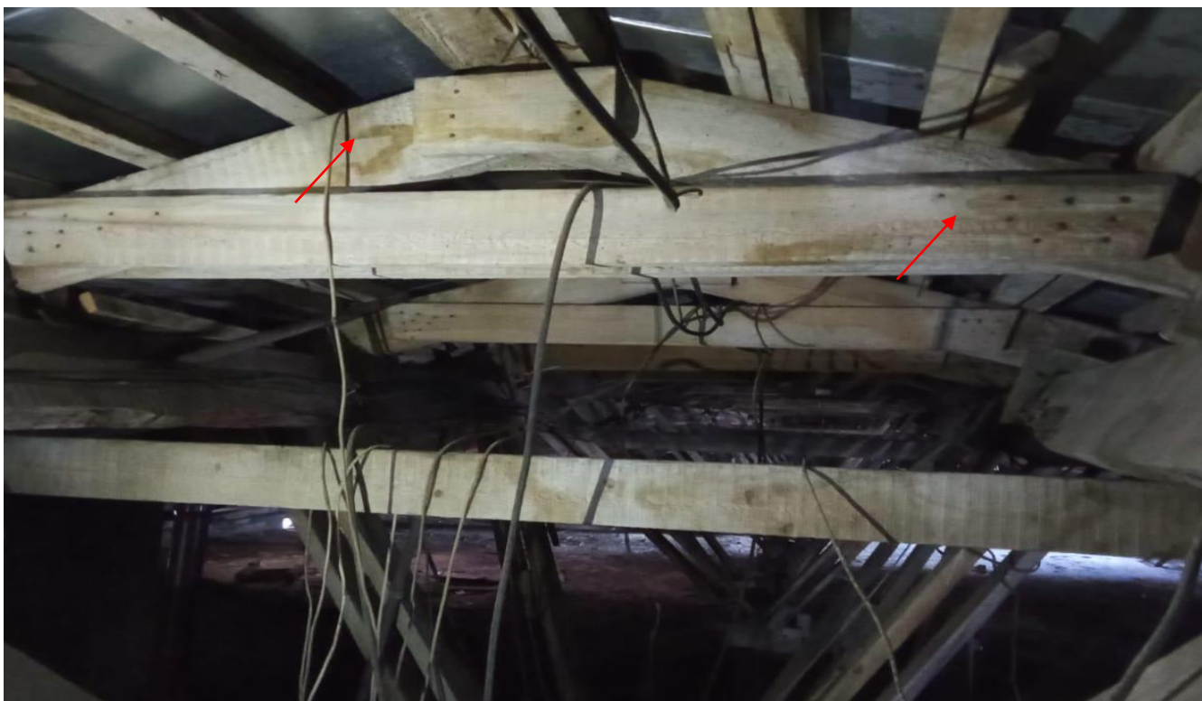
Фото 10. Следы систематического замачивания и гниения стропильной системы
