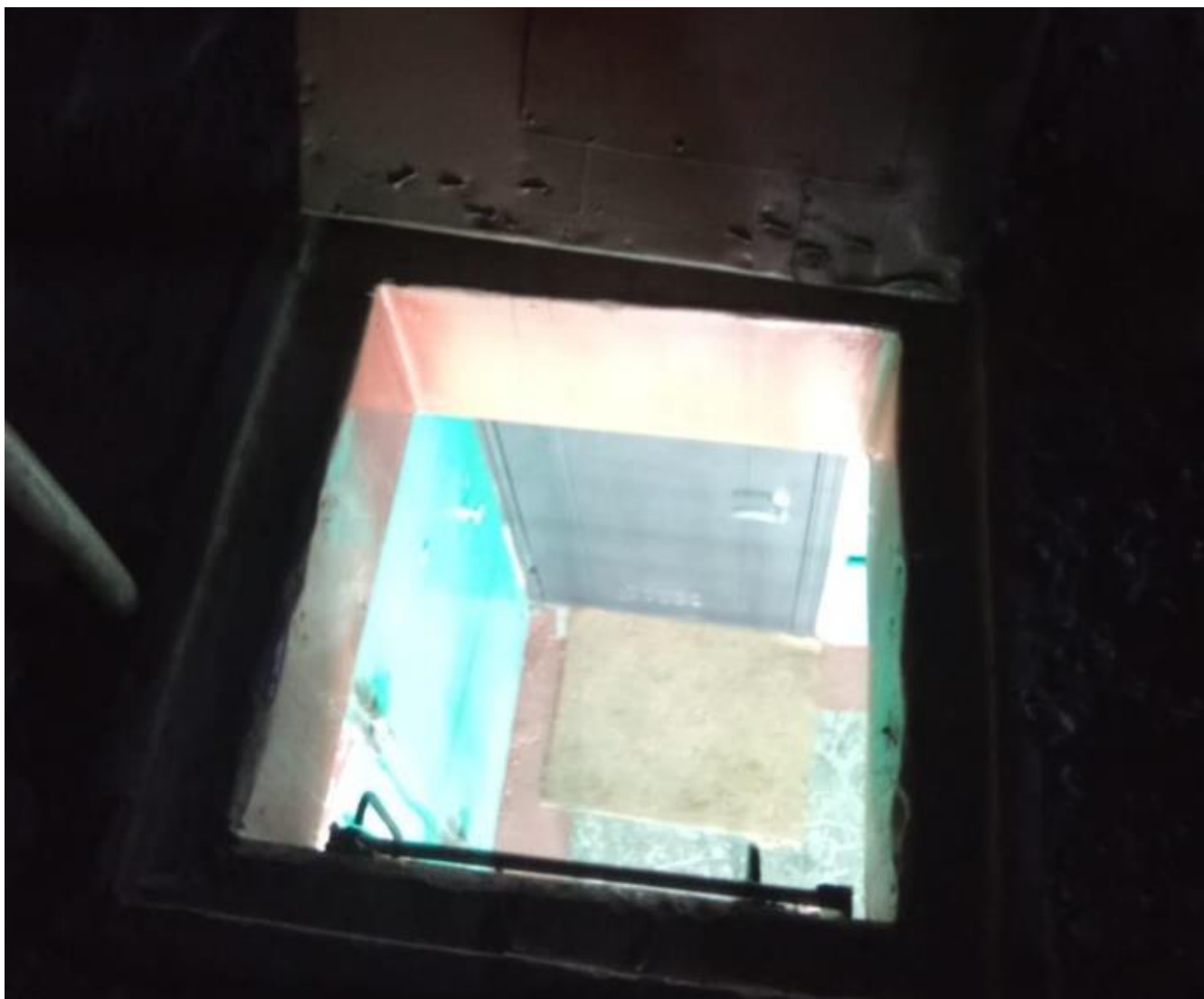
Фото 5. Выход в чердачное помещение не соответствует требованиям пожарной безопасности
