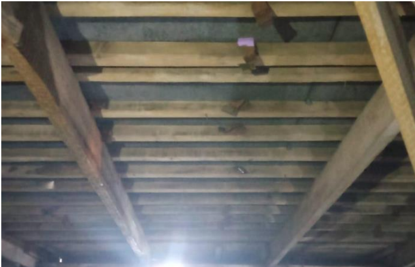
Фото 7. Отсутствие огнебиозащиты стропильных конструкций
