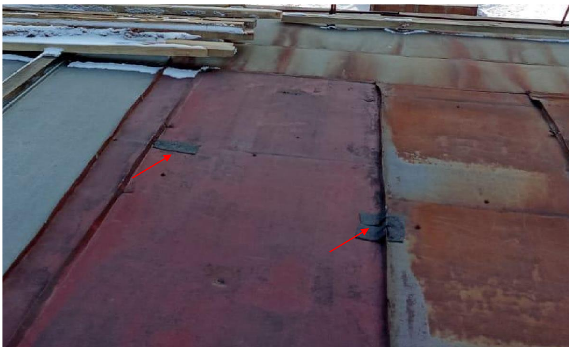
Фото 6. Разрушение кровельных листов крыши здания
