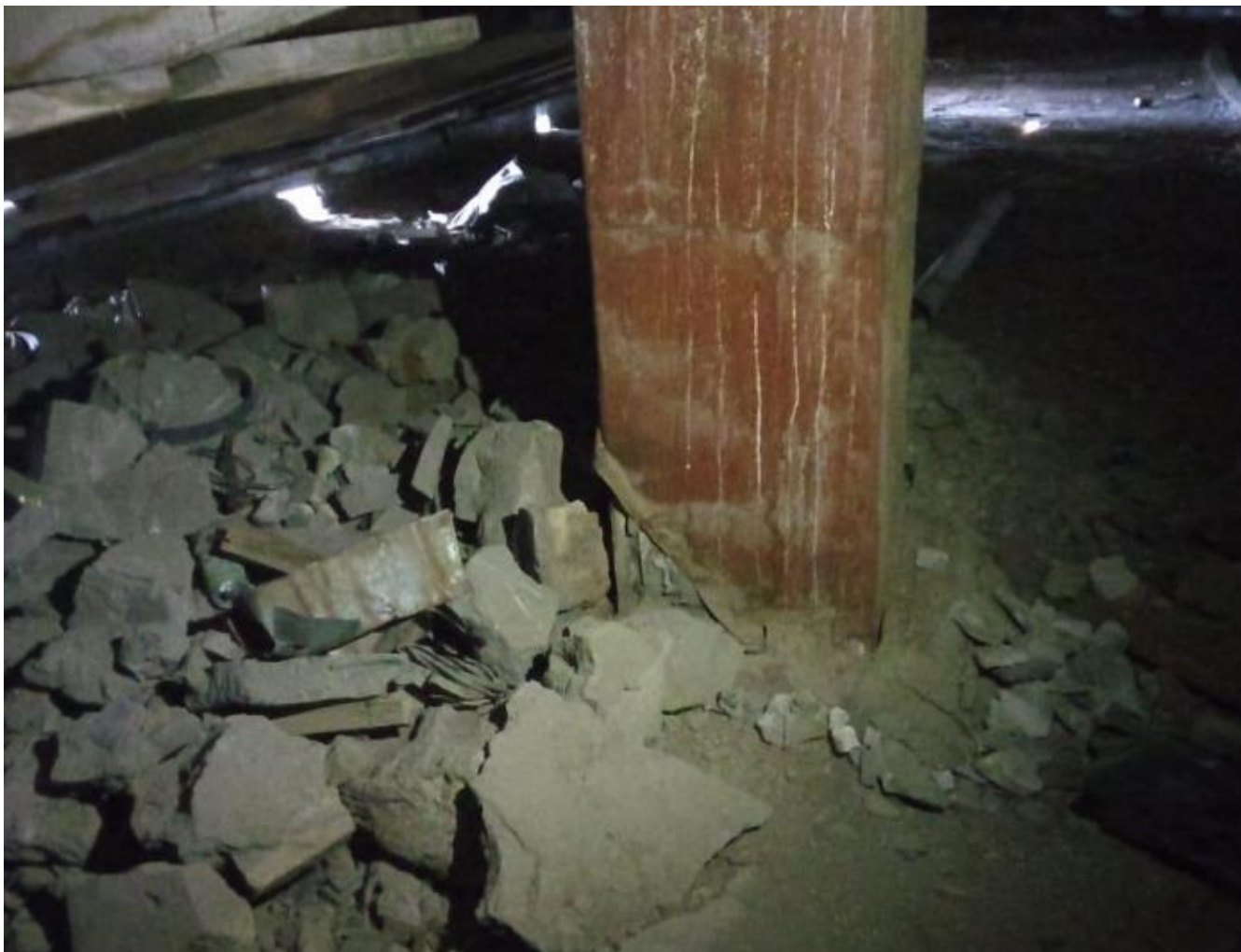
Фото 9. Отсутствие утепление вентиляционных каналов
